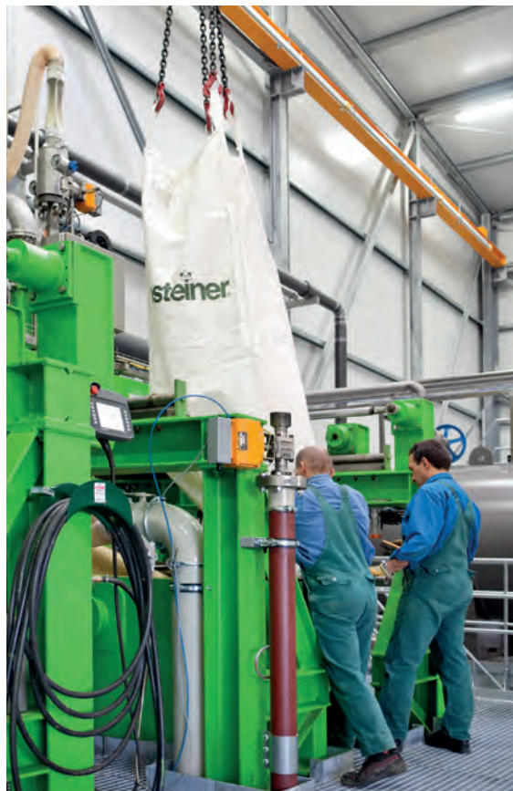
Die CO 2 -Extraktionsanlage wird mit Hopfenpellets gefüllt.
